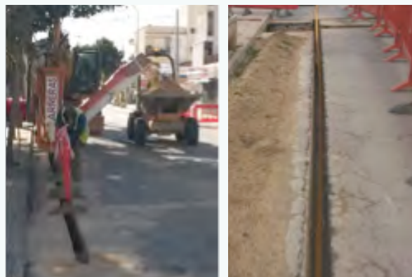
Obras con métodos de alta productividad en Mallorca.
